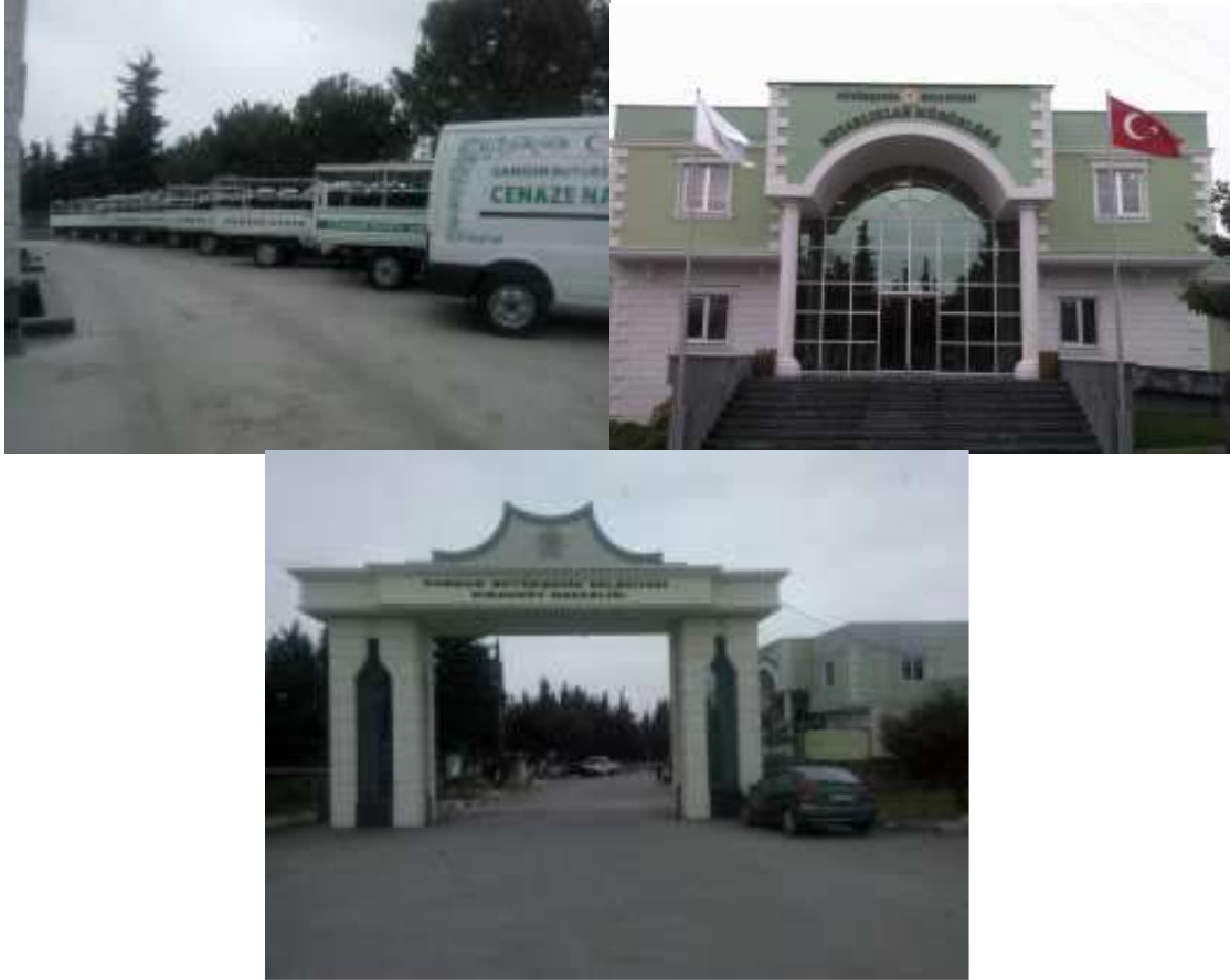
Resim: Mezarlıklar Müdürlüğü İdari Binası
