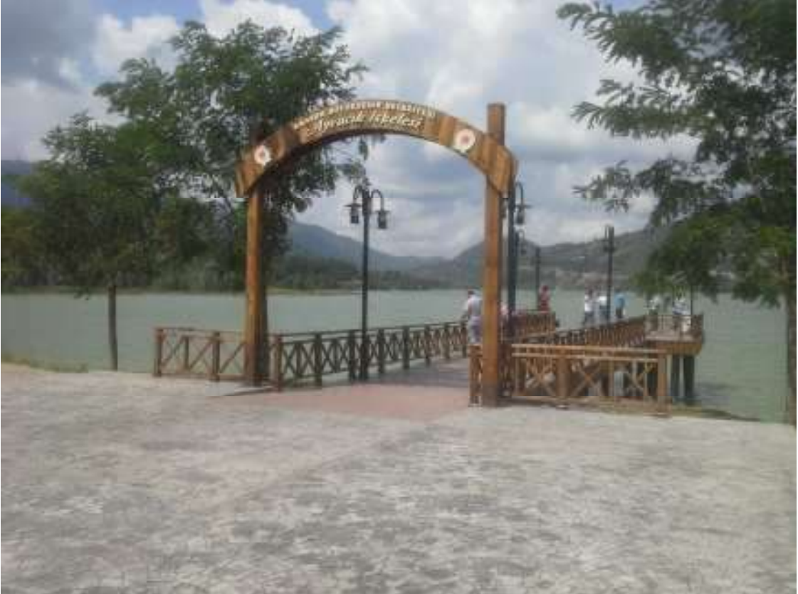
Ayvacak şehir merkezinde yaptığımız iskele
