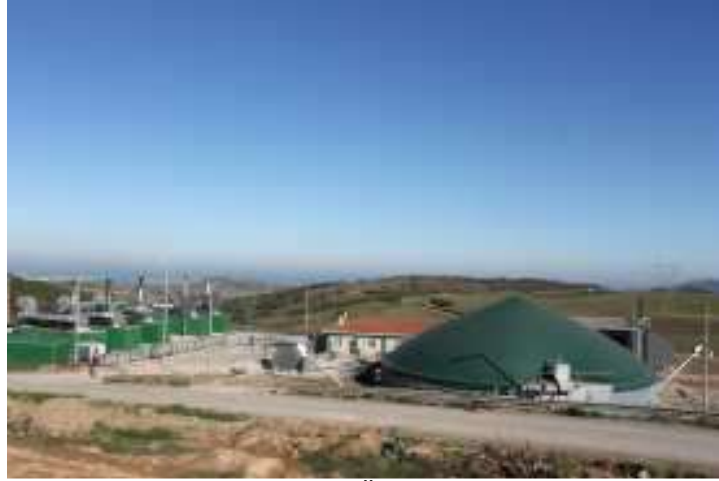
Resim: Samsun Avdan Enerji Ürt. Ve Tic. A.Ş. Biyogaz Tesisi
