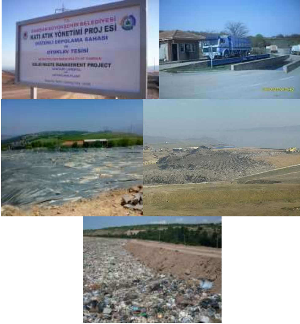
Resim: Kantar Binası ve Depolama Sahası genel ve 2. Lot görüntüleri
