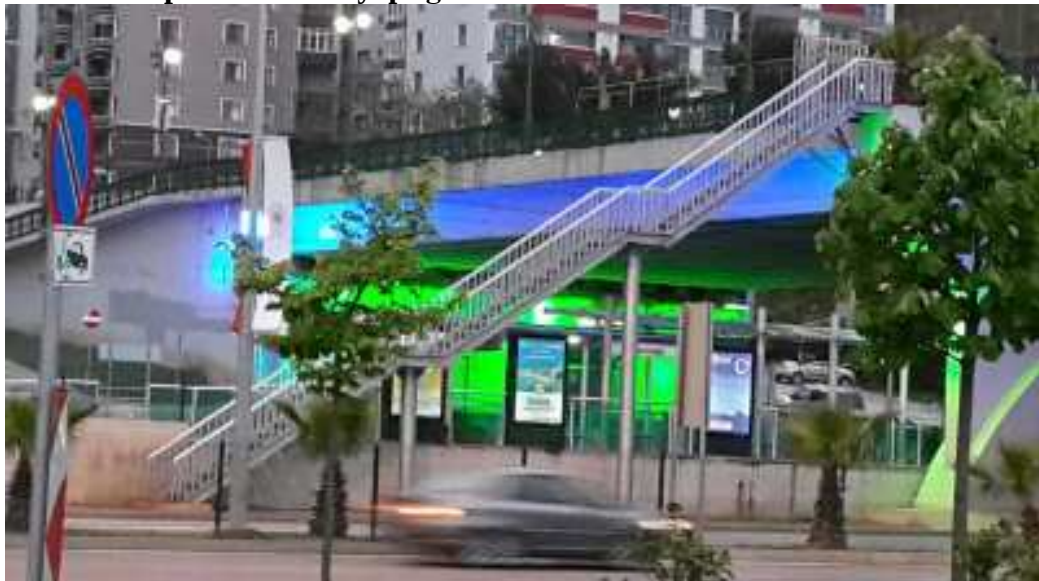
İhlamur köprüsüne ilave yaptığımız merdiven
