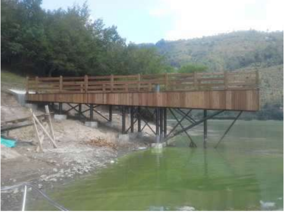
Ayvacak'taki ada üzerinde yaptığımız iskele
