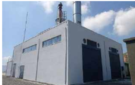
[ Kuzey Biyogaz Tesisi ]
