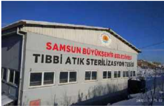
[ Tıbbi Atık Sterilizasyon Tesisi ]
