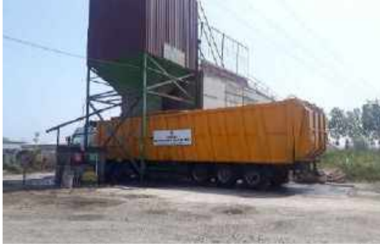
[ Bafra Katı Atık Aktarma İstasyonu ]
