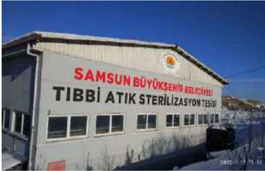
[ Tıbbi Atık Sterilizasyon Tesisi ]
