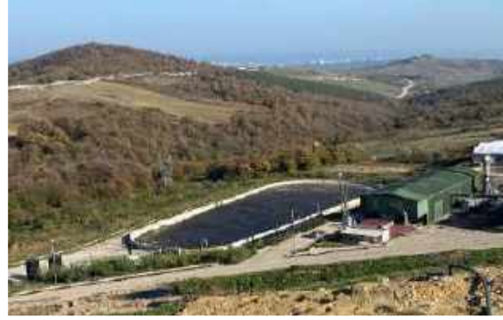
[ Sızıntı Suyu Havuzu ]
