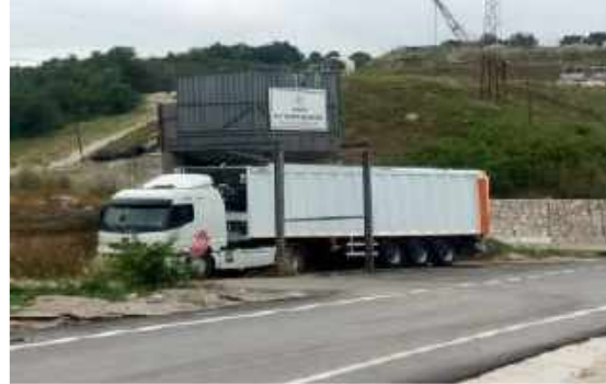
[ Kavak Katı Atık Aktarma İstasyonu ]
