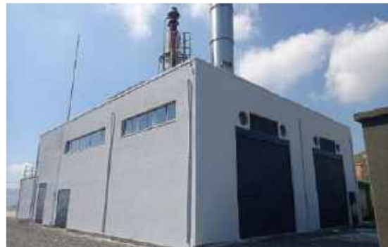
[ Kuzey Biyogaz Tesisi ]
