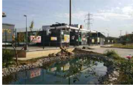
[ Çarşamba Katı Atık Düzenli Depolama Sahası ve Enerji Üretim Tesisi ]
