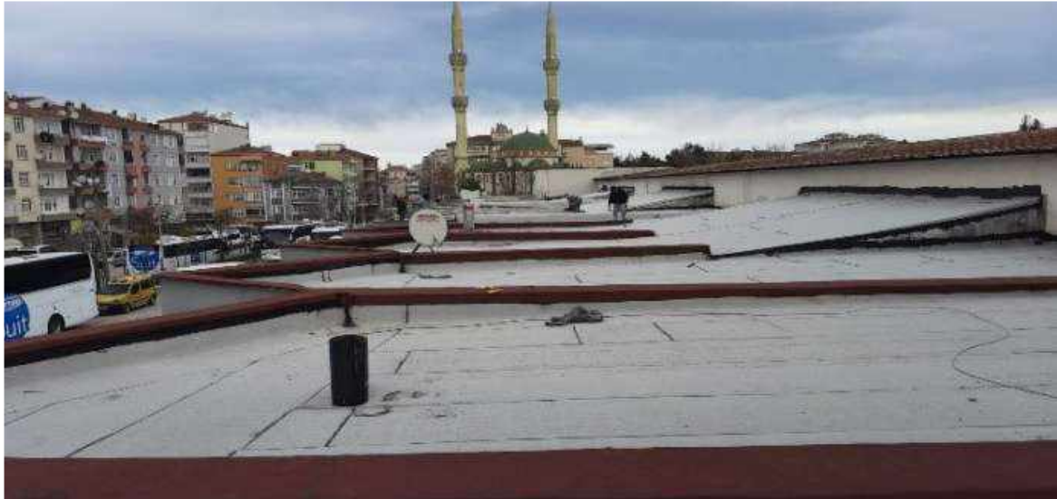
[ Baflra Şehirler Arası Yolcu Terminali Çatı Tadilatı ]
