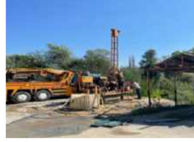
[ Havza İlçesi Tersakan Çayı Köprüsü Zemin Etüdü ]
