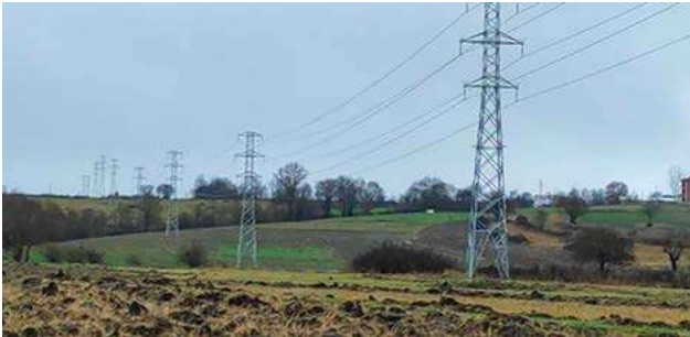
Ladik Güneş Enerji Santrali Projesine Ait Görseller
