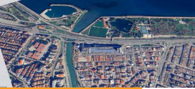
Canik, Piazza Avm Önü Yol, Tretuvar, TT Durak Cebi Geometrik Düzenleme Projesi
