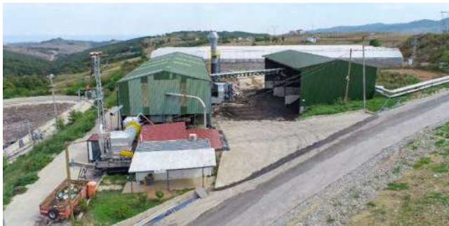
Çamur Kurutma Tesisi
