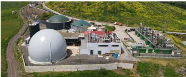
Metan Gazından Elektrik Üretim ve Kuzey Biyogaz Tesisi
