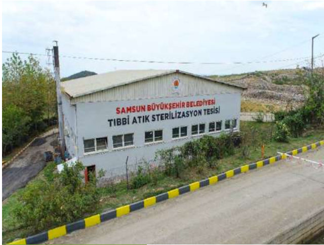
Tıbbi Atık Sterilizasyon Tesisi
