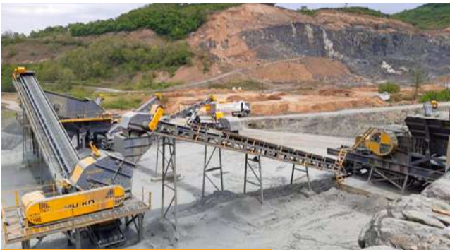
Çarşamba Orduköy Kırma Eleme Tesisi
