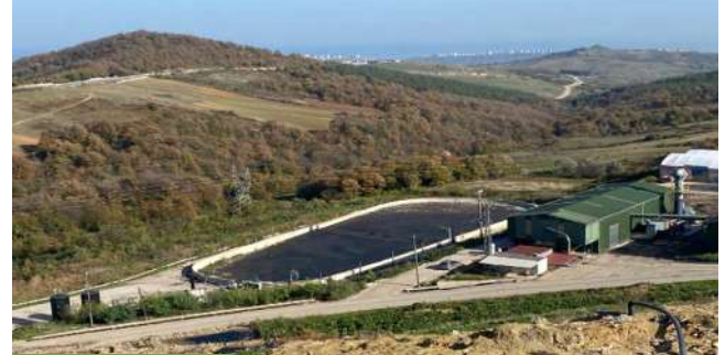
Sızıntı Suyu Havuzu
