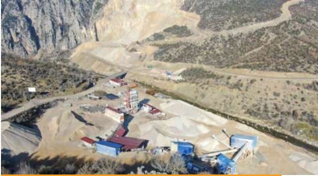
Vezirköprü Çalköy Kalker Taş Ocağı ve Kırma Eleme Tesisi
